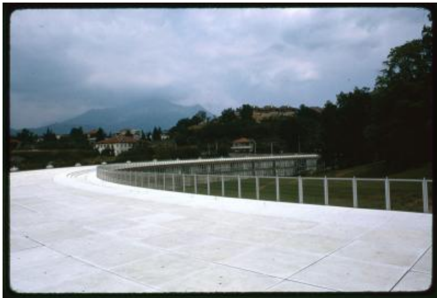
Ivrea. Unità residenziale Ovest Olivetti Talponia vista dal tetto
