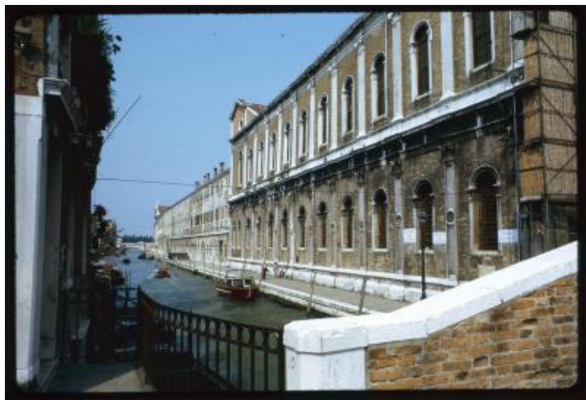
Venezia. Fiancata della Scuola Grande di San Marco prospiciente il Rio dei Mendicanti
