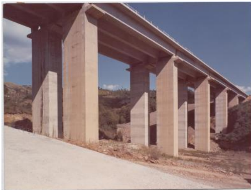
Viadotto sul fiume Serra a Lagonegro, per l'autostrada Salerno-Reggio Calabria
