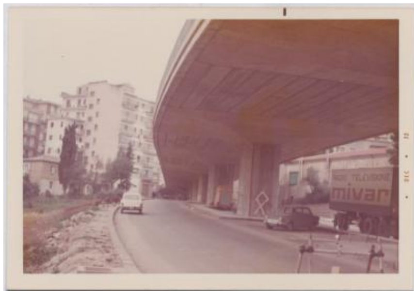
Sopraelevata urbana a Cosenza per il raccordo della S.S. 107 con l'autostrada Salerno-Reggio Calabria
