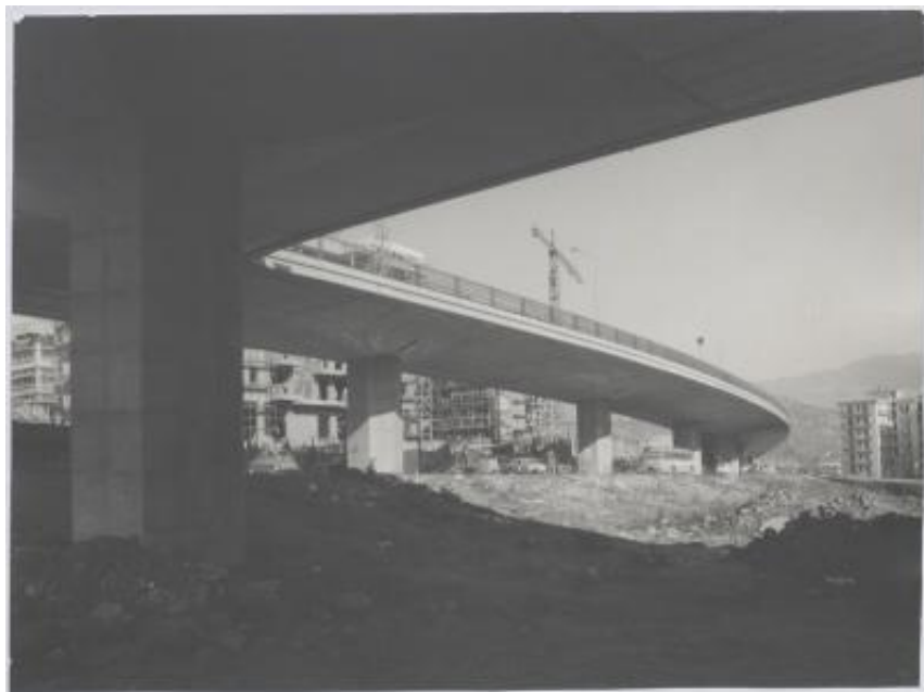
Sopraelevata urbana a Cosenza per il raccordo della S.S. 107 con l'autostrada Salerno-Reggio Calabria
