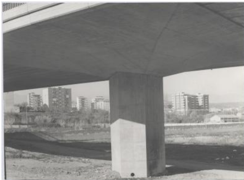
Sopraelevata urbana a Cosenza per il raccordo della S.S. 107 con l'autostrada Salerno-Reggio Calabria
