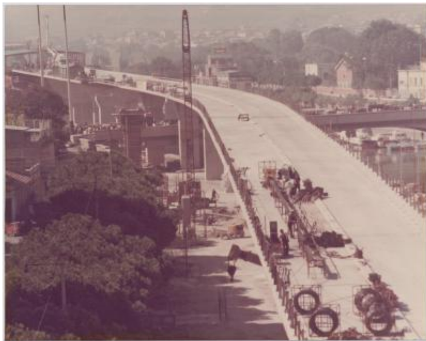
Sopraelevata lungofiume a Pescara
