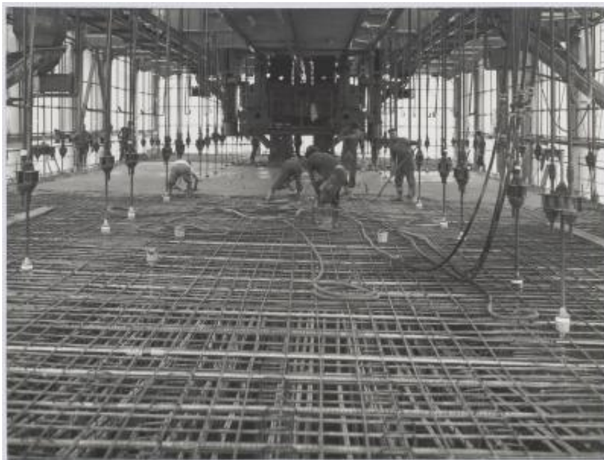
Viadotto sul fiume Tanaro, Alessandria, per l'Autostrada dei trafori
