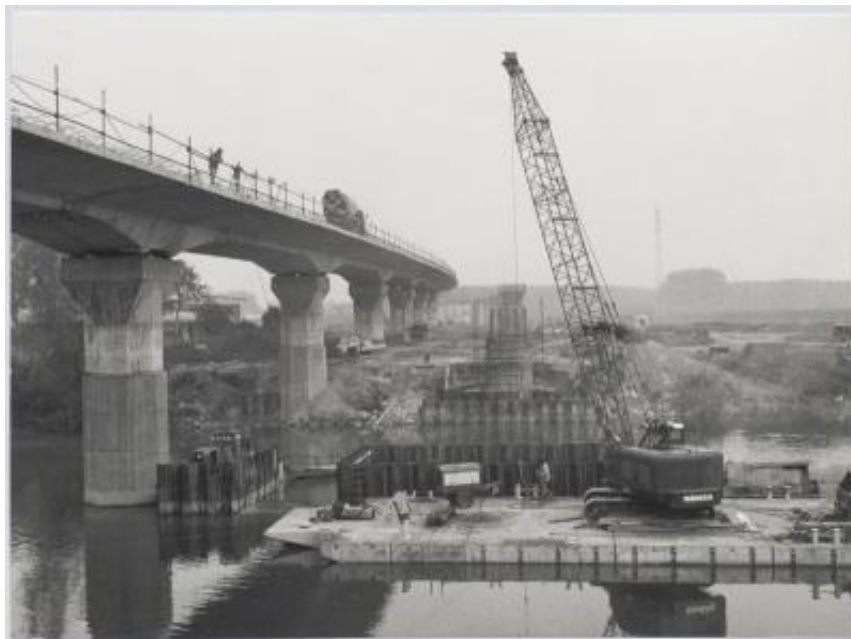
Viadotto sul fiume Tanaro, Alessandria, per l'Autostrada dei trafori
