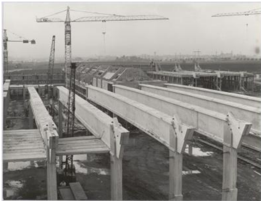
Costruzione della Centrale del latte a Roma
