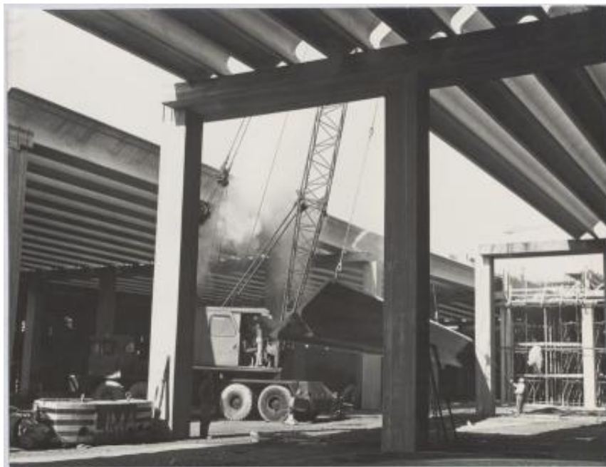
Costruzione della Centrale del latte a Roma
