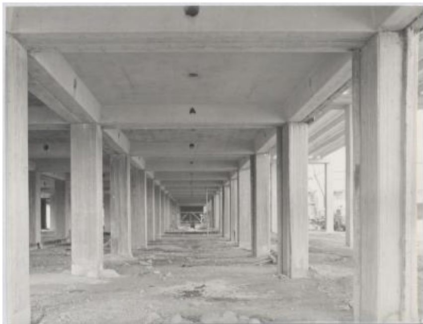
Costruzione della Centrale del latte a Roma
