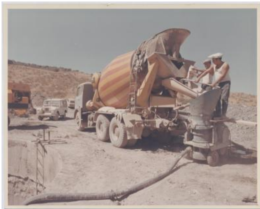
Viadotto sul torrente Fichera per l'autostrada Palermo-Catania
