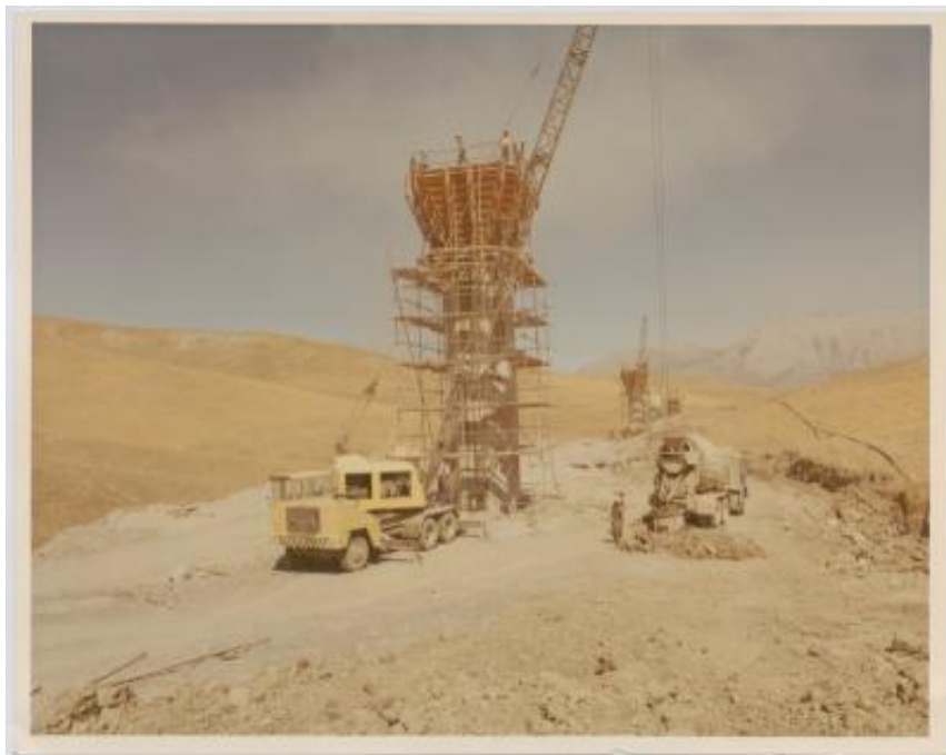
Viadotto sul torrente Fichera per l'autostrada Palermo-Catania
