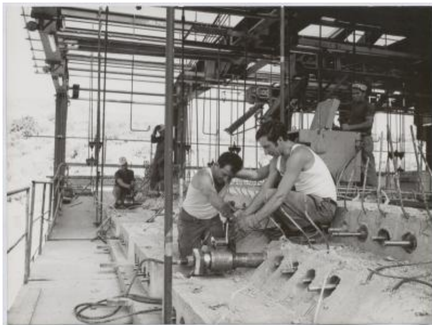
Viadotto sul torrente Fichera per l'autostrada Palermo-Catania
