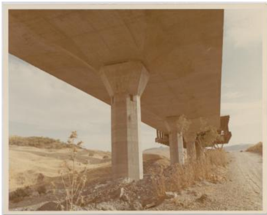
Viadotto sul torrente Fichera per l'autostrada Palermo-Catania
