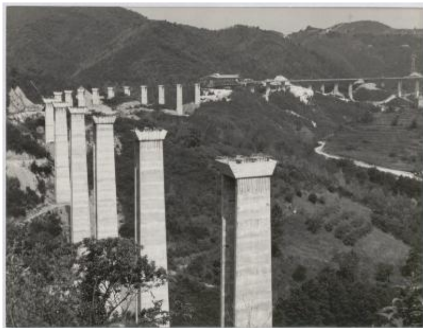
Viadotto sul torrente Teccio, Quiliano (SV), per l'autostrada Torino-Savona
