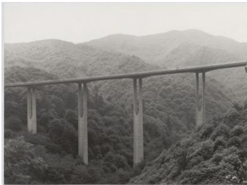
Viadotto sul torrente Teccio, Quiliano (SV), per l'autostrada Torino-Savona
