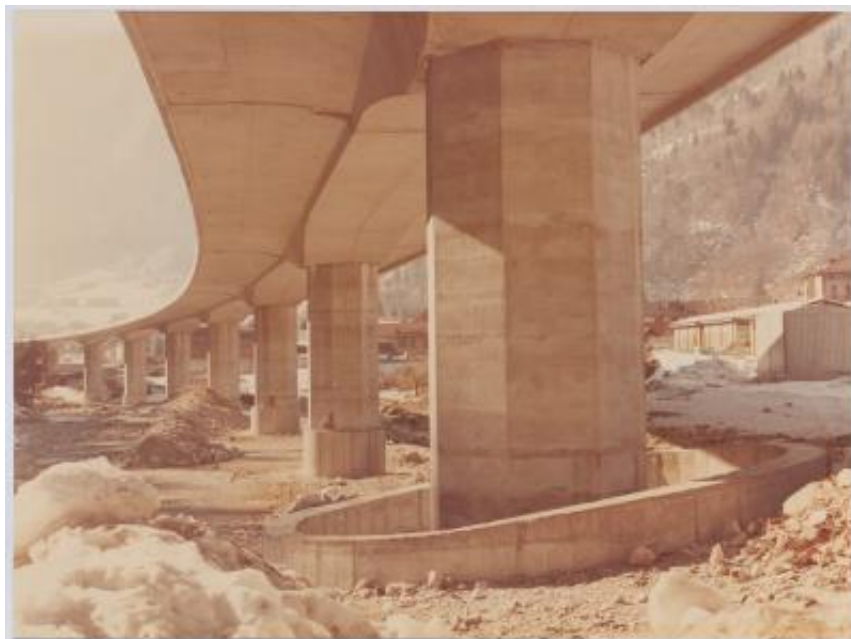
Viadotti Pontebba e Pietratagliata per la S.S. 13 "Pontebbana", Pontebba e Pietratagliata (UD)
