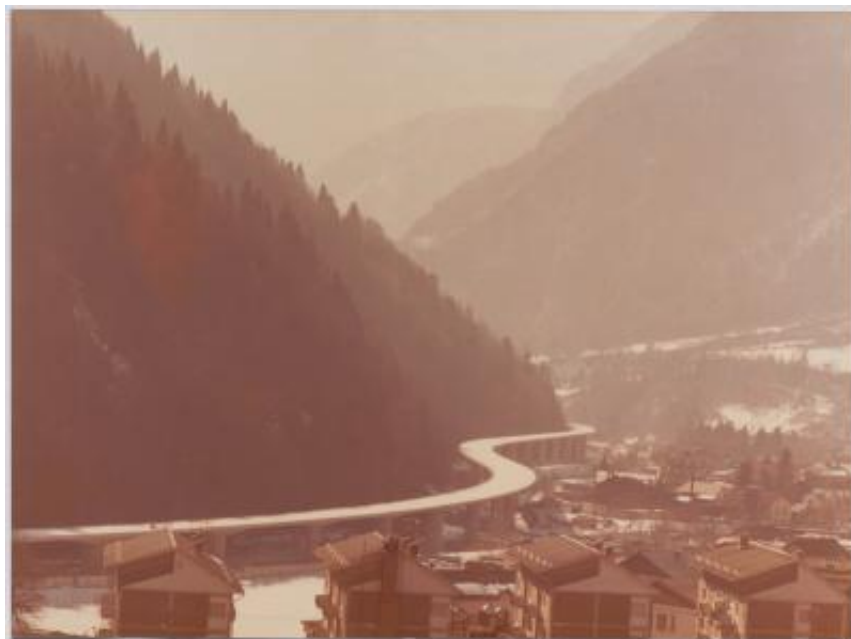
Viadotti Pontebba e Pietratagliata per la S.S. 13 "Pontebbana", Pontebba e Pietratagliata (UD)
