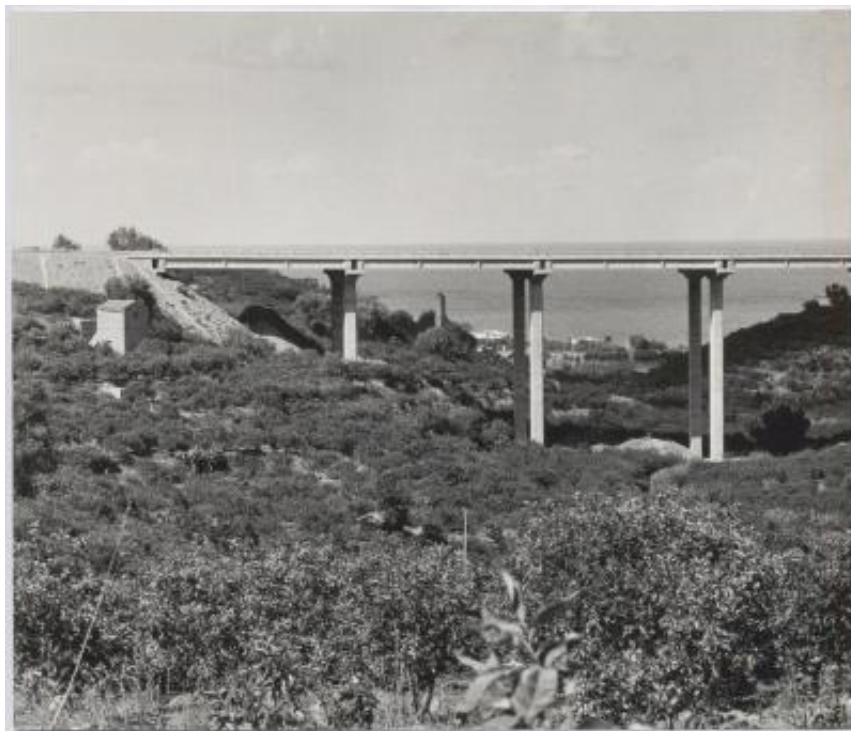
Impalcati prefabbricati utilizzati nella realizzazione dell'autostrada Catania-Messina
