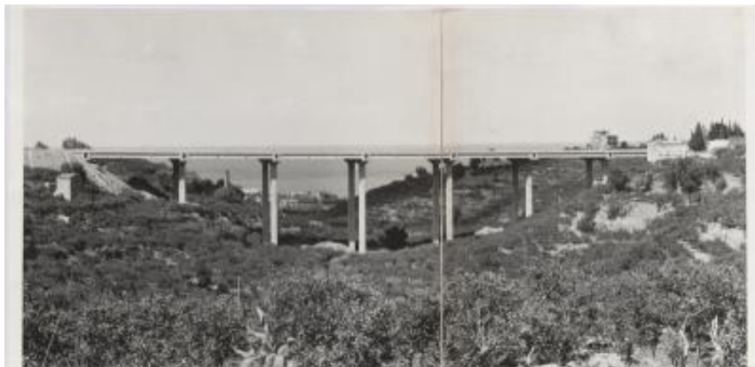
Impalcati prefabbricati utilizzati nella realizzazione dell'autostrada Catania-Messina
