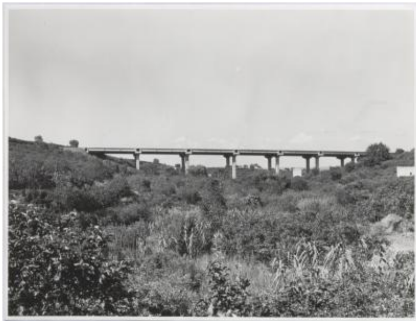
Impalcati prefabbricati utilizzati nella realizzazione dell'autostrada Catania-Messina
