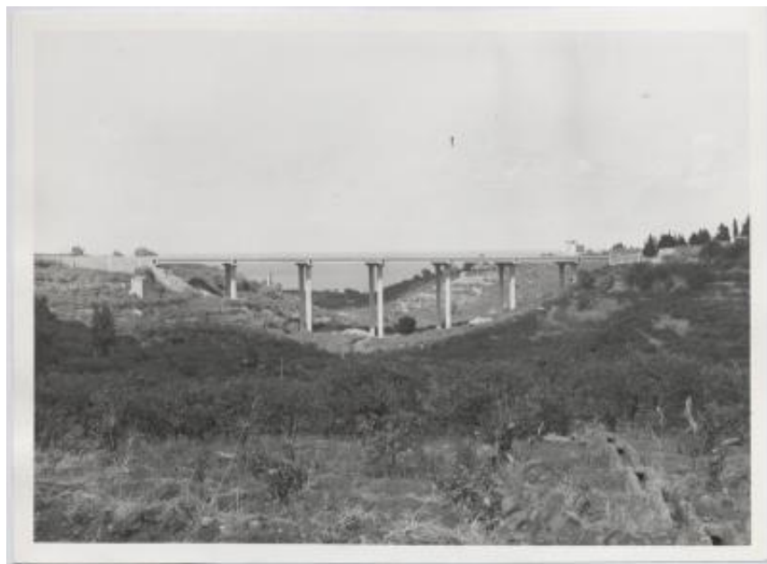
Impalcati prefabbricati utilizzati nella realizzazione dell'autostrada Catania-Messina
