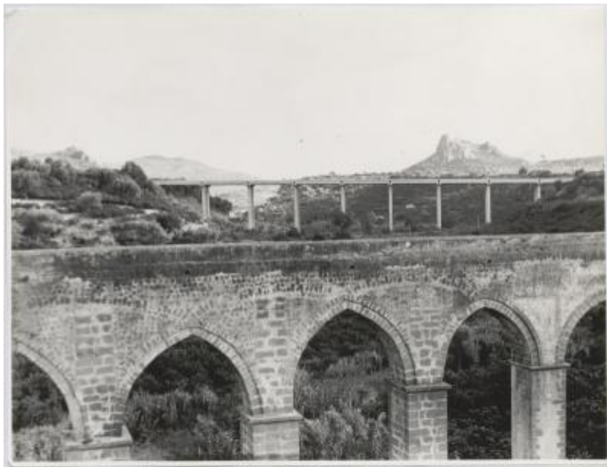
Impalcati prefabbricati utilizzati nella realizzazione dell'autostrada Catania-Messina
