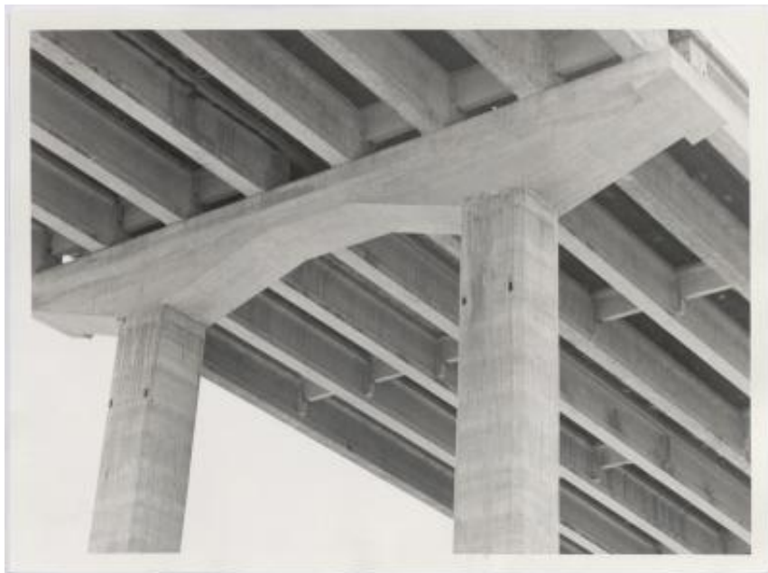
Impalcati prefabbricati utilizzati nella realizzazione dell'autostrada Catania-Messina
