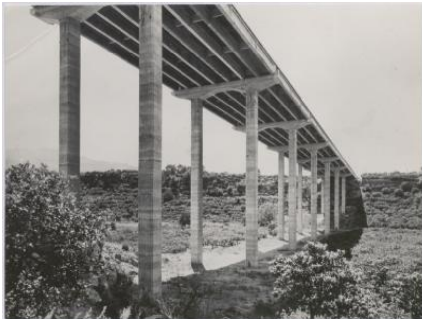
Impalcati prefabbricati utilizzati nella realizzazione dell'autostrada Catania-Messina
