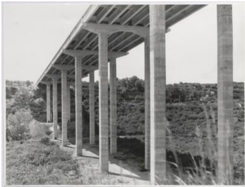
Impalcati prefabbricati utilizzati nella realizzazione dell'autostrada Catania-Messina
