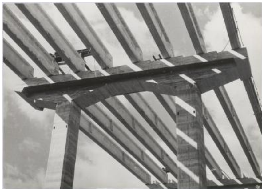
Impalcati prefabbricati utilizzati nella realizzazione dell'autostrada Catania-Messina
