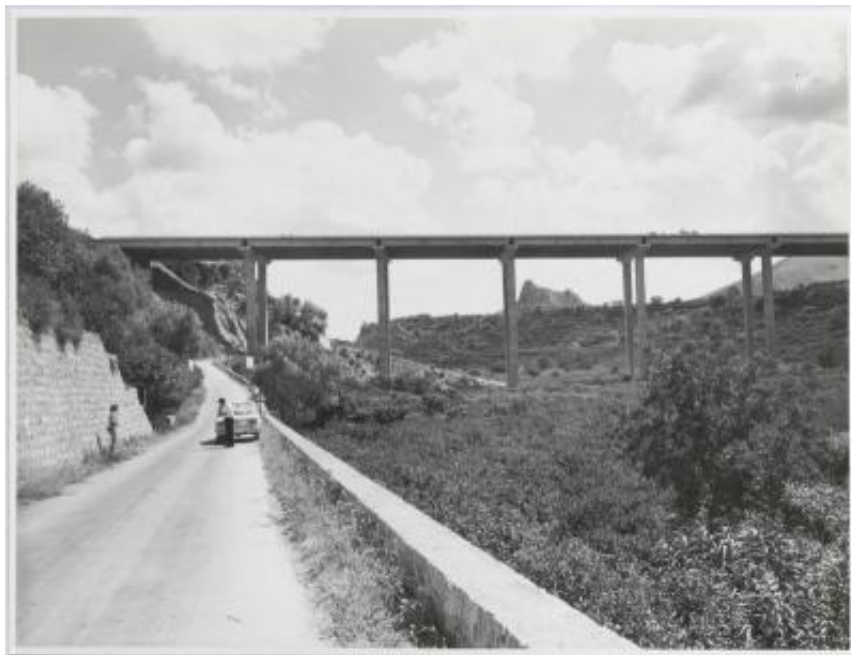
Impalcati prefabbricati utilizzati nella realizzazione dell'autostrada Catania-Messina
