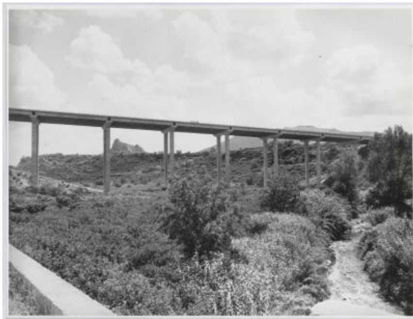
Impalcati prefabbricati utilizzati nella realizzazione dell'autostrada Catania-Messina
