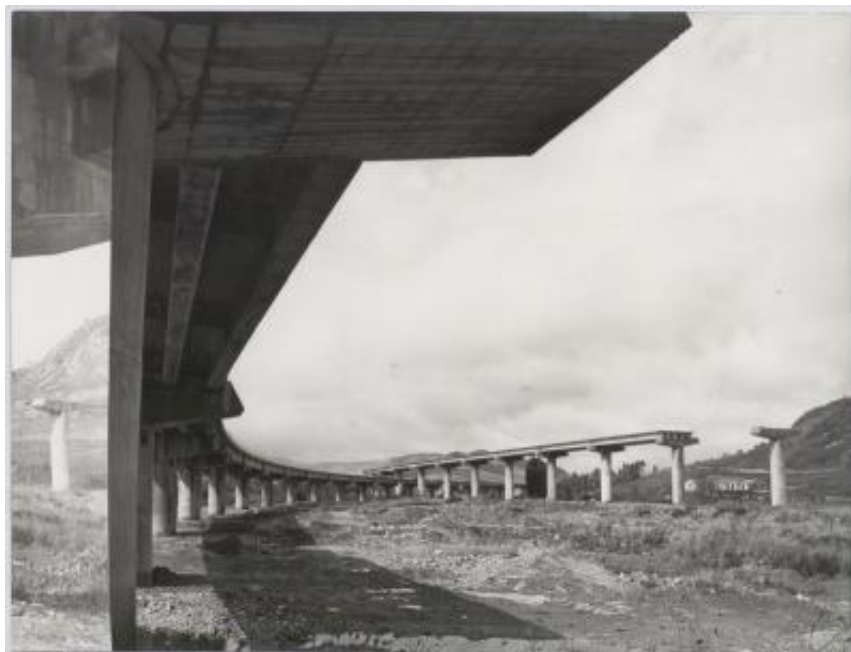
Impalcati prefabbricati utilizzati nella realizzazione dell'autostrada Catania-Messina
