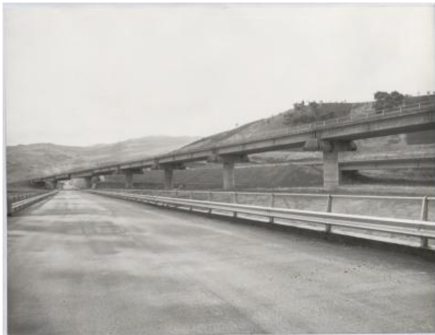
Impalcati prefabbricati utilizzati nella realizzazione dell'autostrada Catania-Messina
