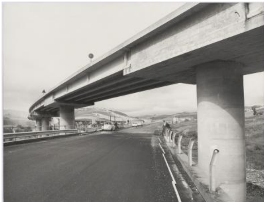
Impalcati prefabbricati utilizzati nella realizzazione dell'autostrada Catania-Messina
