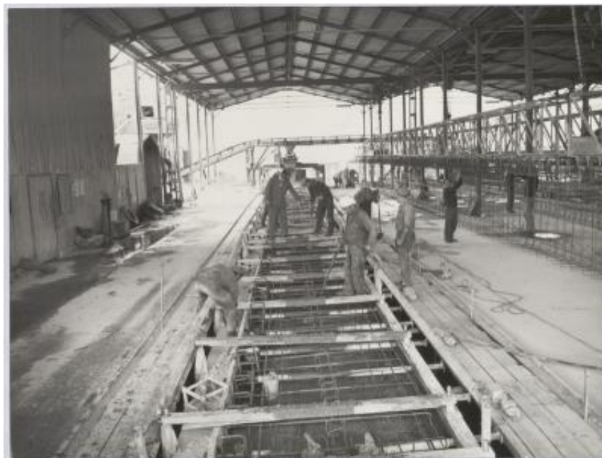
Impalcati prefabbricati utilizzati nella realizzazione dell'autostrada Catania-Messina
