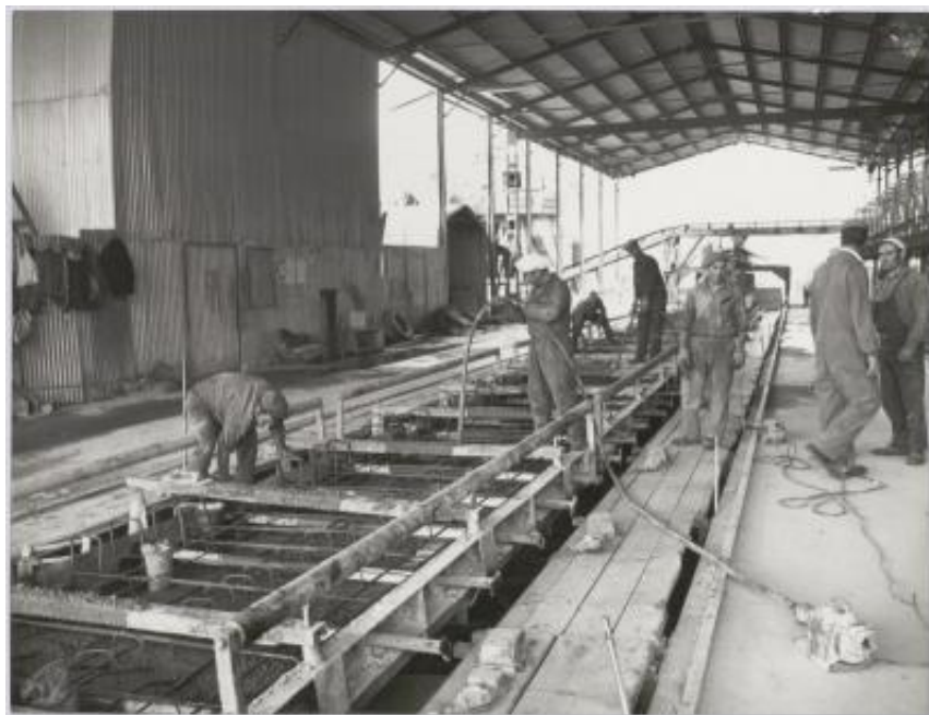
Impalcati prefabbricati utilizzati nella realizzazione dell'autostrada Catania-Messina
