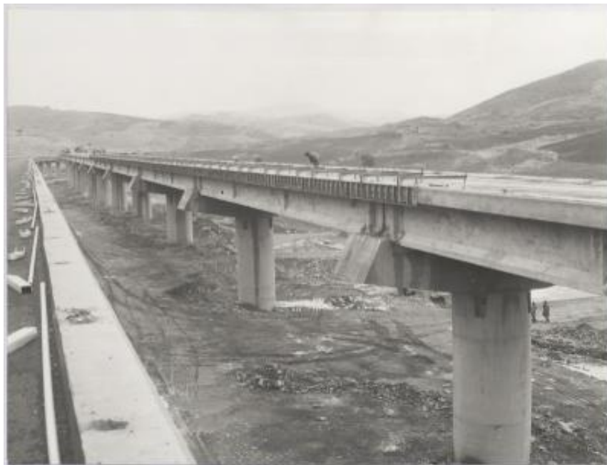
Impalcati prefabbricati utilizzati nella realizzazione dell'autostrada Catania-Messina
