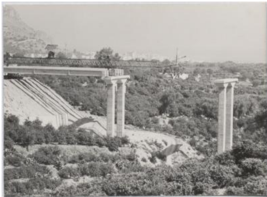
Impalcati prefabbricati utilizzati nella realizzazione dell'autostrada Catania-Messina
