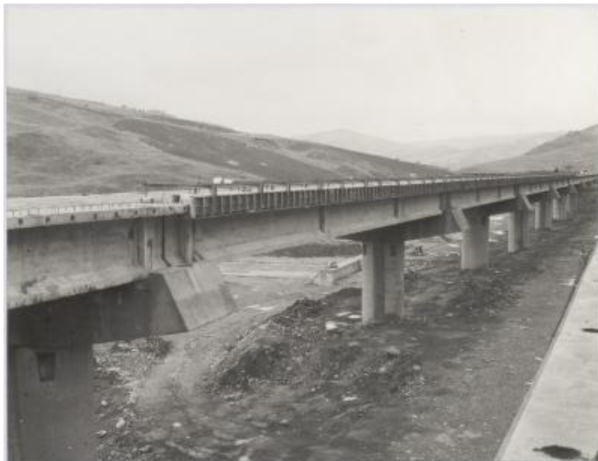
Impalcati prefabbricati utilizzati nella realizzazione dell'autostrada Catania-Messina
