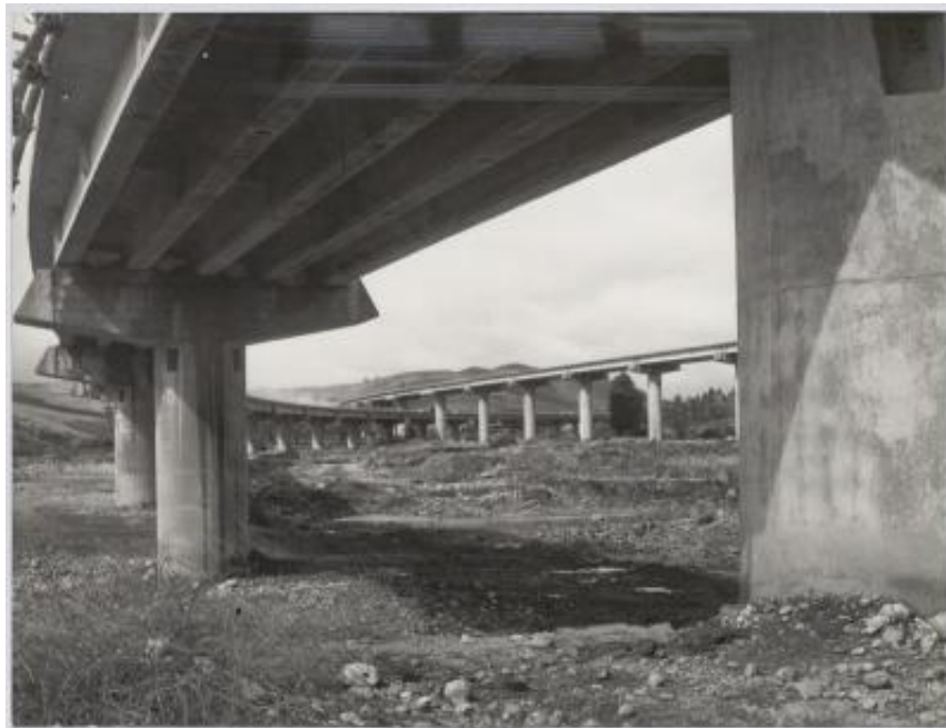
Impalcati prefabbricati utilizzati nella realizzazione dell'autostrada Catania-Messina
