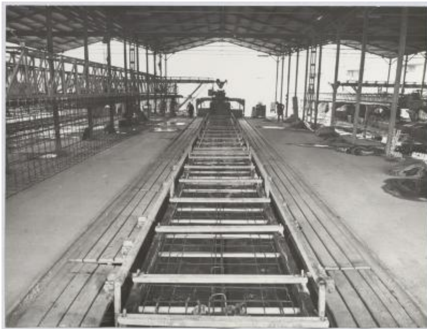
Impalcati prefabbricati utilizzati nella realizzazione dell'autostrada Catania-Messina
