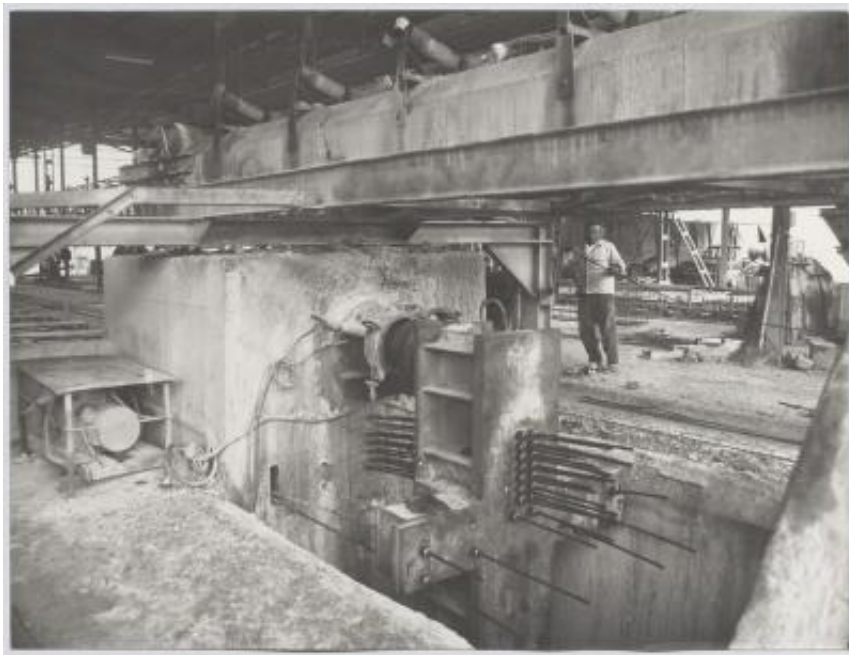
Impalcato prefabbricato utilizzato nella realizzazione dell'autostrada Catania-Messina
