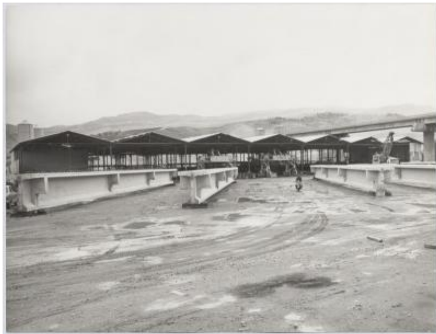
Impalcati prefabbricati utilizzati nella realizzazione dell'autostrada Catania-Messina
