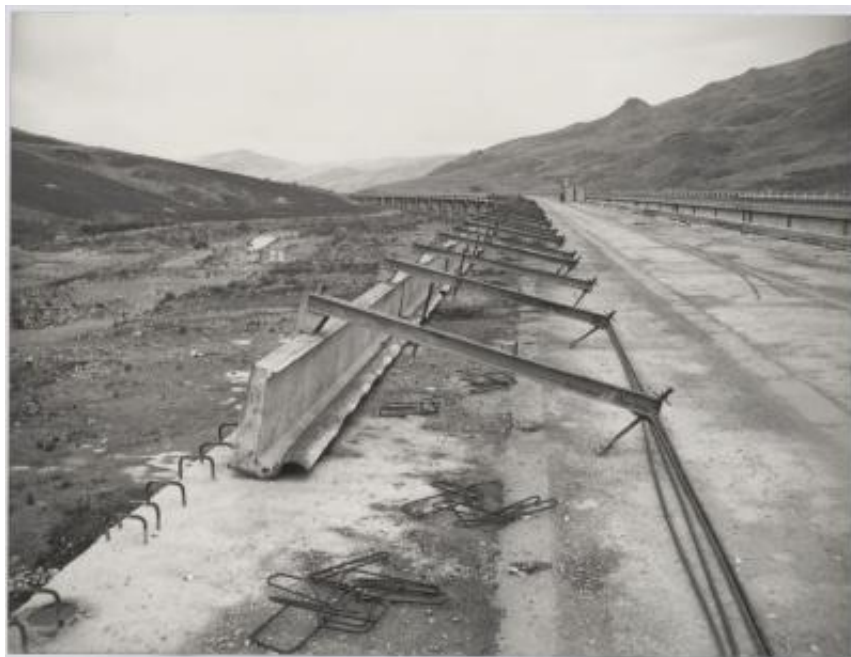
Impalcati prefabbricati utilizzati nella realizzazione dell'autostrada Catania-Messina
