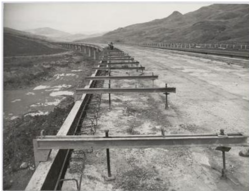
Impalcati prefabbricati utilizzati nella realizzazione dell'autostrada Catania-Messina
