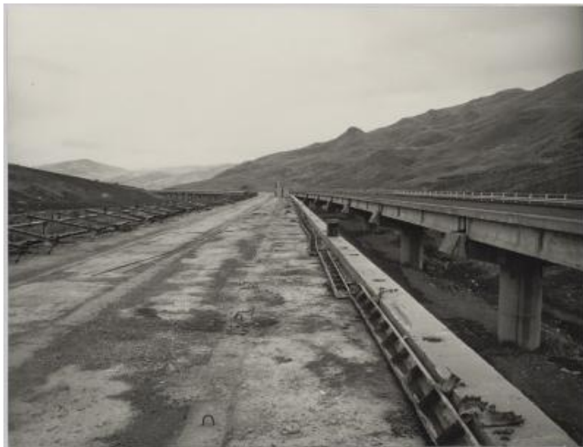
Impalcati prefabbricati utilizzati nella realizzazione dell'autostrada Catania-Messina
