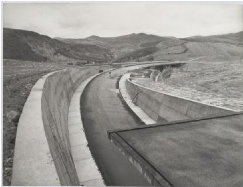
Impalcati prefabbricati utilizzati nella realizzazione dell'autostrada Catania-Messina
