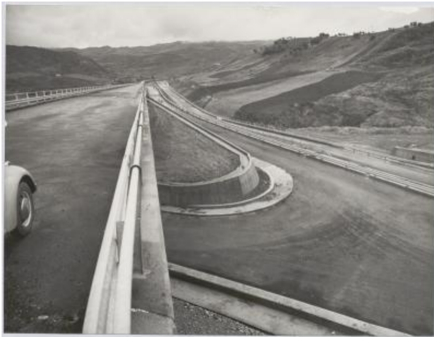
Impalcati prefabbricati utilizzati nella realizzazione dell'autostrada Catania-Messina
