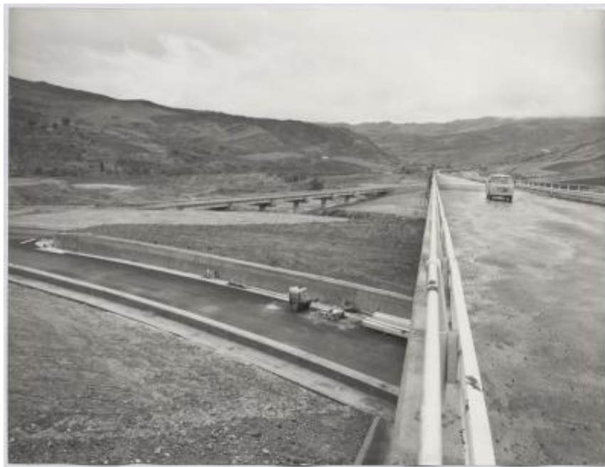
Impalcati prefabbricati utilizzati nella realizzazione dell'autostrada Catania-Messina
