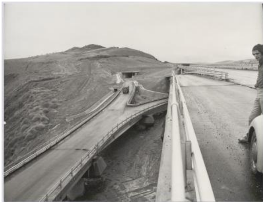
Impalcati prefabbricati utilizzati nella realizzazione dell'autostrada Catania-Messina
